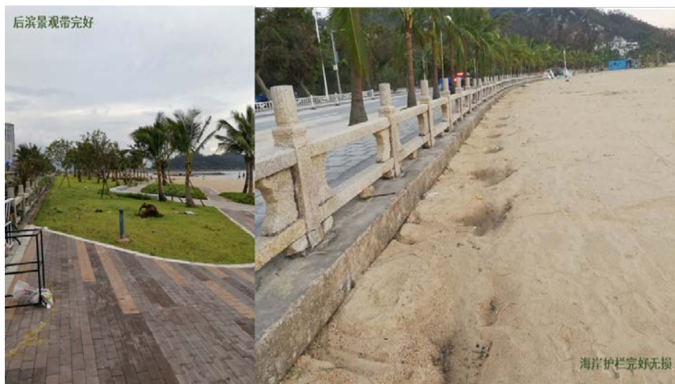
图 19 超强台风期间，受沙滩保护的海岸护栏和后滨设施完好无损
