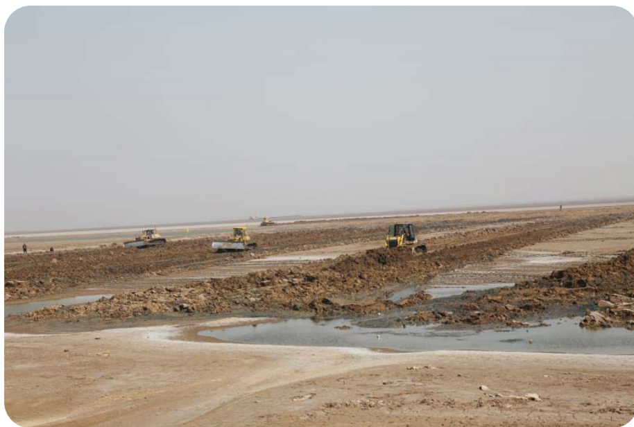
图 10 垦东咸水沟退养还湿修复前（图片来源：本手册编制单位）
