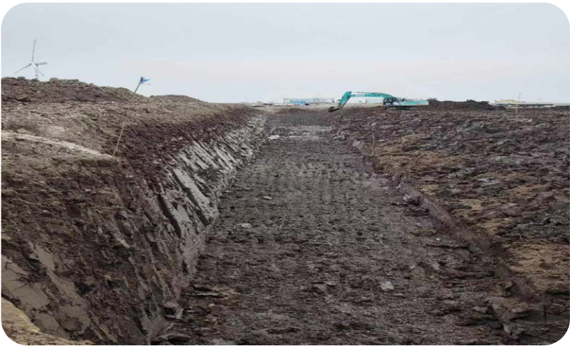
图 15 潮沟疏通现场施工照片（图片来源：本手册编制单位）
