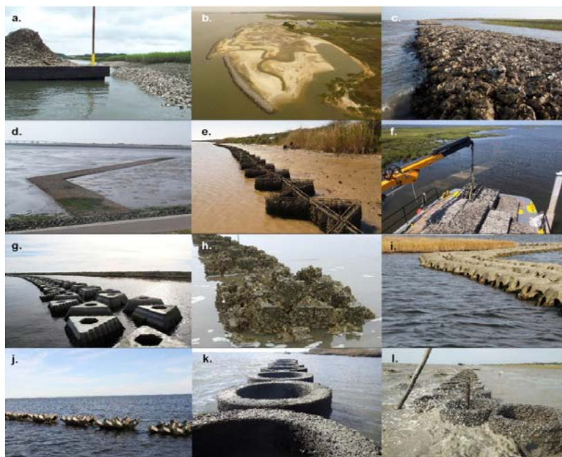
图 19 以岸线防护为目的构建的潮间带牡蛎礁 [12]
