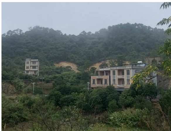
项目西面冲湓村散户
