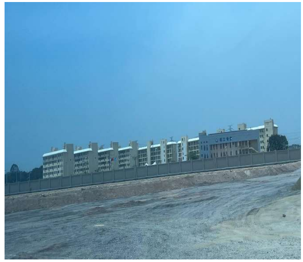
广西华昇宿舍区（高纯铝项目北面）
