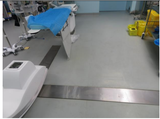
图 3-8 机房内走地电缆
