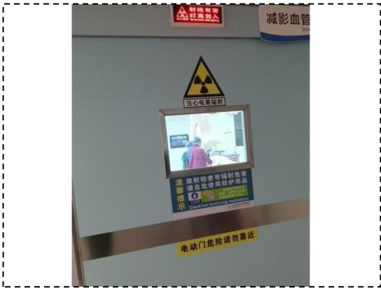
图 3-5 病人出入机房防护门及警示标志
