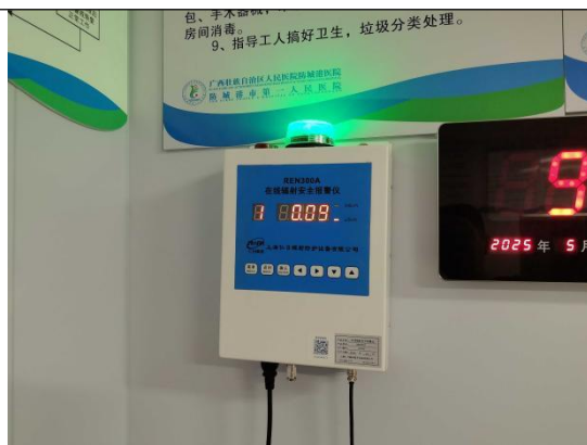
图 3-23 REN300A 型在线辐射安全报警仪
