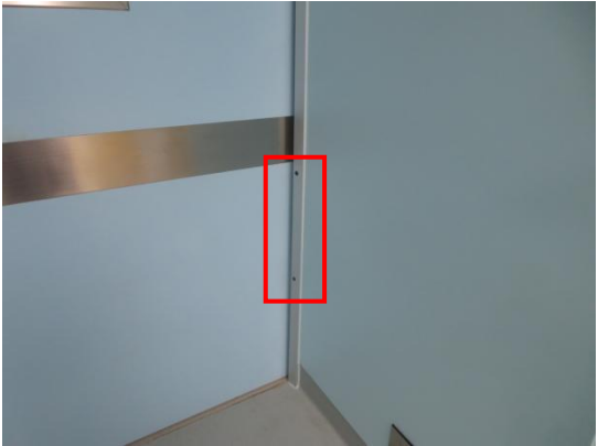
图 3-6 病人出入机房防护门及防夹装置
