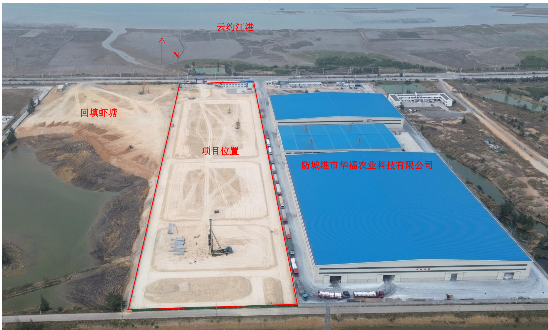
项目现场航拍（拍摄时间 2026 年 1 月）
